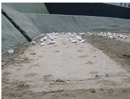
写真－29 中間覆土代替材 3ヵ月経過状況
