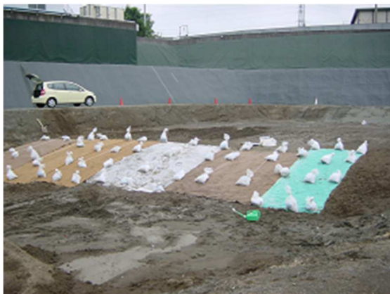
写真－24 即日覆土代替材施工後状況
