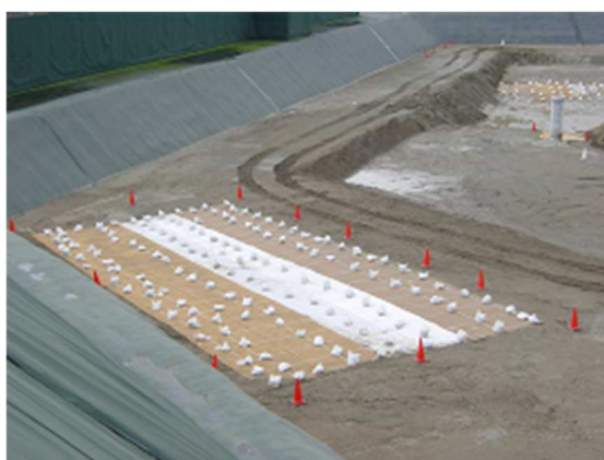
写真－27 中間覆土代替材台風通過直後 (施工直後)
