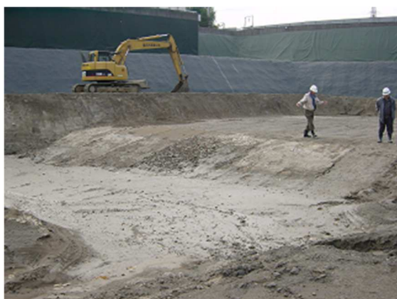
写真－28 即日覆土代替材 3ヵ月経過状況
