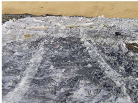
写真－3 散水後のシート状況
