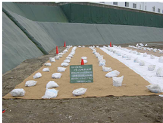
写真－25 中間覆土代替材施工後状況
