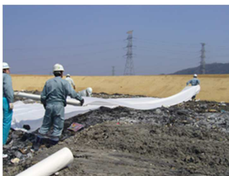
写真－1 デイリーキャップ敷設状況
