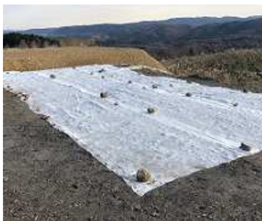
写真-5 石によるシート固定方法(ボランスODDC-80)
