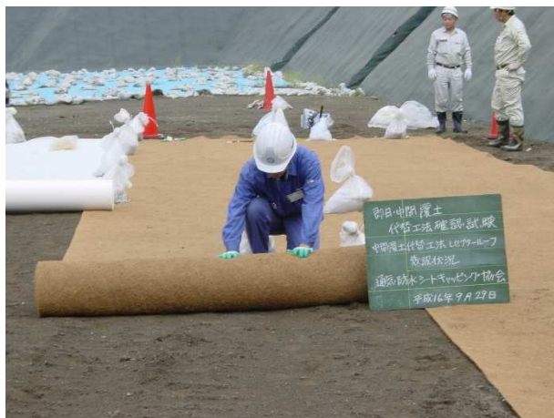
写真－7 レセプタールーフB敷設状況
