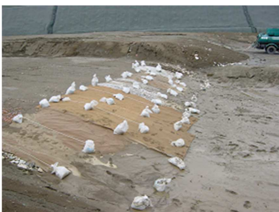
写真－26 即日覆土代替材台風通過直後 (施工直後)
