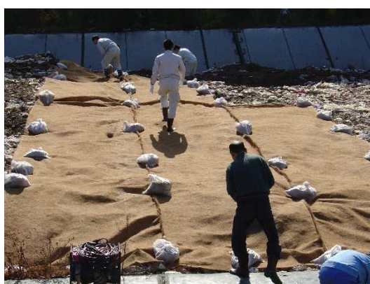
写真-4 土のうによるシート固定方法(レセプタールーフA)
