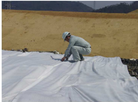
写真－2 ラップ部のホチキスによるジョイント状況
